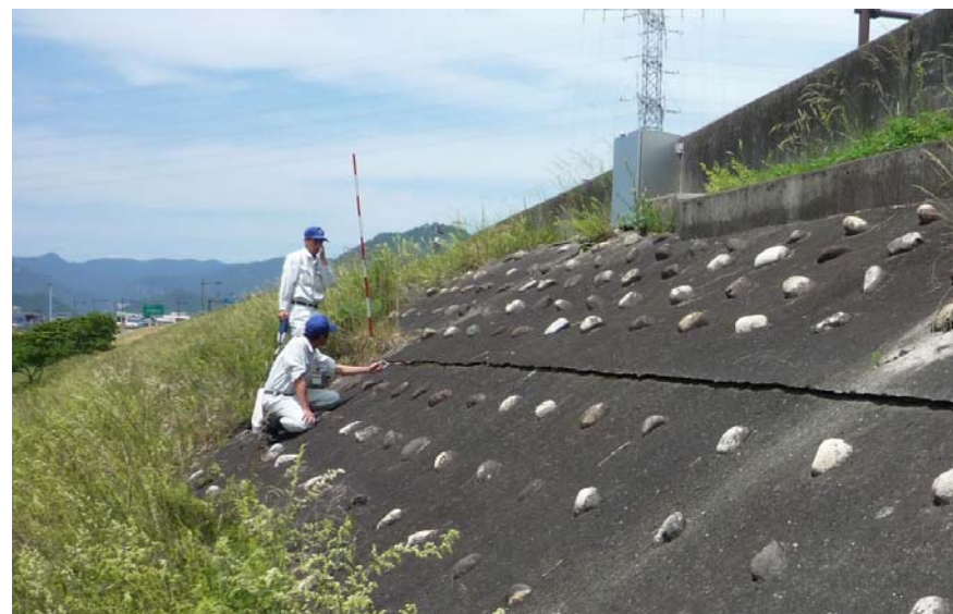
堤防点検の状況
