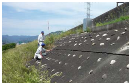
13 堤防点検の状況
