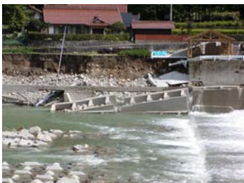
10 山県郡安芸太田町大字加計地先
