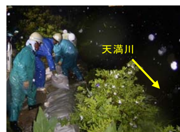
観音地区の土のう積み状況
