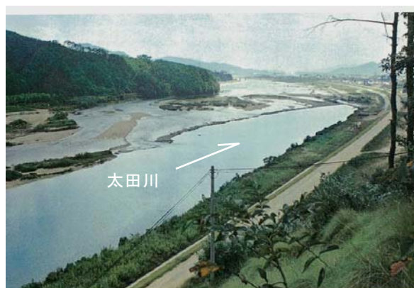
建設前(昭和46年9月)
