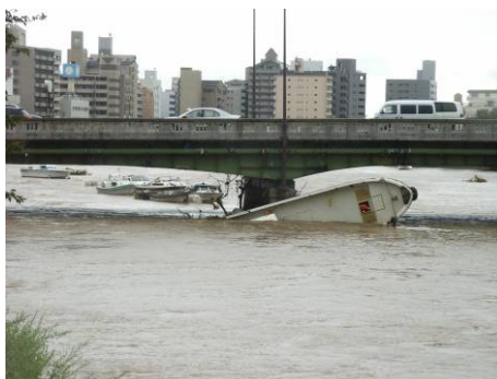
橋脚に引っ掛かったプレジャーボート
