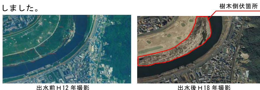
図 3.1.12 太田川下流部 9.0k 付近の樹木倒伏状況
