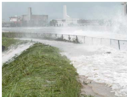
平成16年高潮による浸水状況 (広島市西区観音付近)
