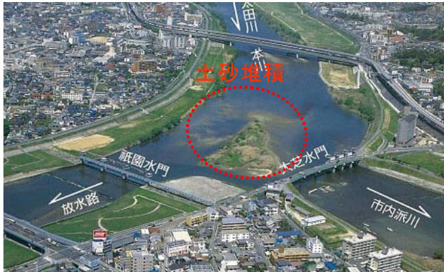
分派地点の土砂堆積状況
