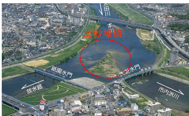
分派地点の土砂堆積状況
