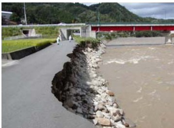
9 山県郡安芸太田町大字上殿地先
