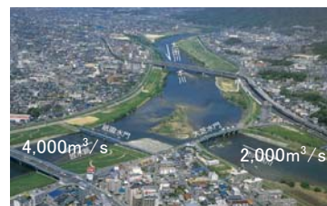
現在の分派地点の状況
