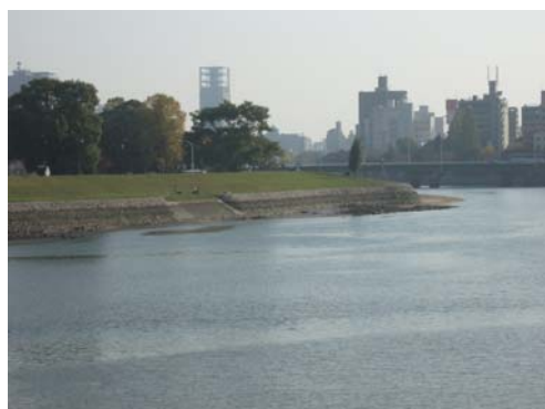
基町環境護岸（下流デルタ域）
