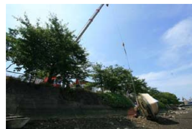
沈船の撤去
