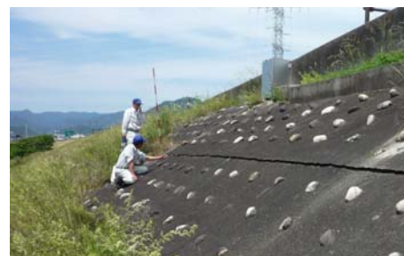
堤防点検の状況
