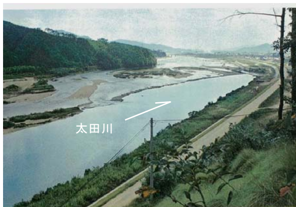
30 建設前(昭和46年9月)
