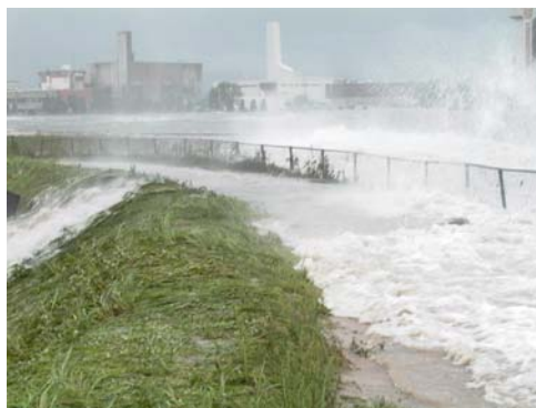
平成16年高潮による浸水状況 (広島市西区観音付近)
