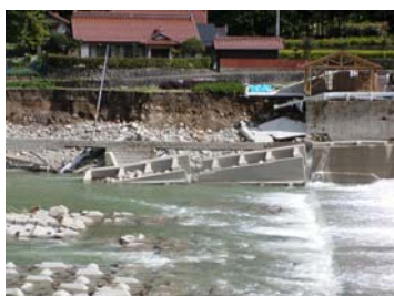
10 山県郡安芸太田町大字加計地先
