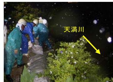
観音地区の土のう積み状況
