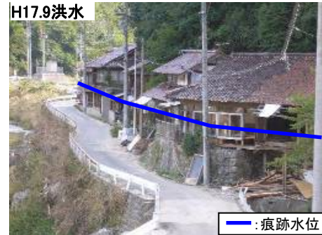
太田川の洪水氾濫状況 (広島市安佐北区安佐町大字久地地先)
