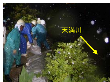
観音地区の土のう積み状況
