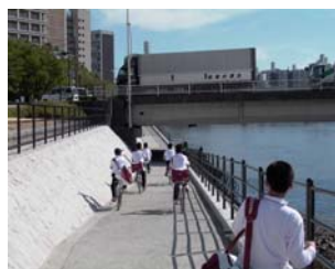
北大橋左岸のアンダーパス
