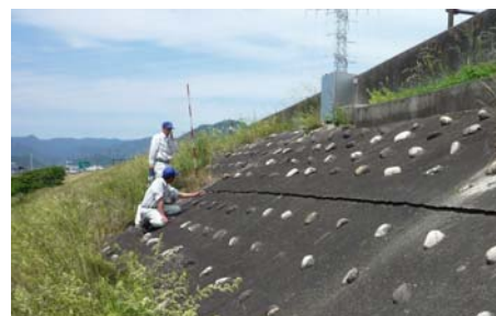
堤防点検の状況
