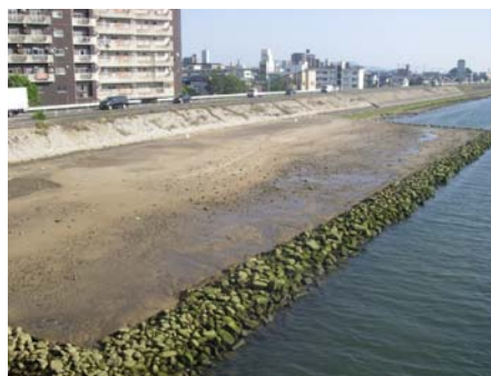
「太田川生態工学研究会」において実施されている干潟再生試験で造成された干潟の状況写真
