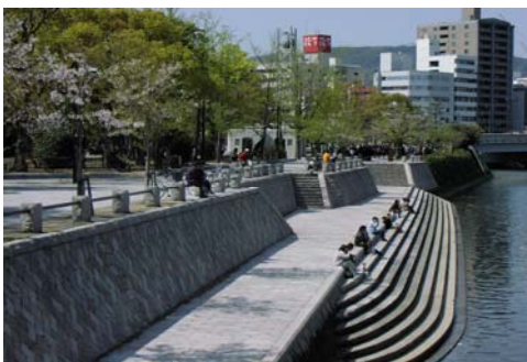
平和記念公園における河岸(親水テラス)整備 (元安川)
