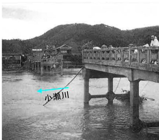
大和橋落橋の跡
