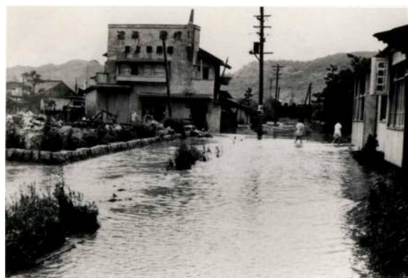
大竹町内(当時)の浸水状況
