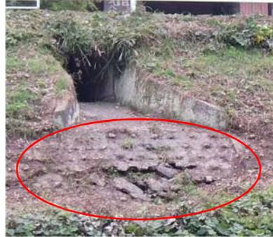
補強コンクリートの剥離
