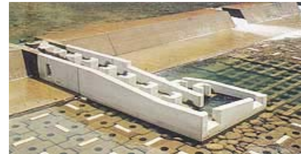
改善された魚道(久日市堰堤:加計町)
