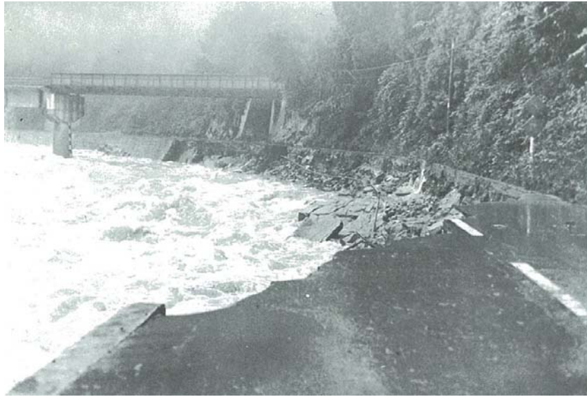
戸河内地区 柴木川国道191号野為橋上流
