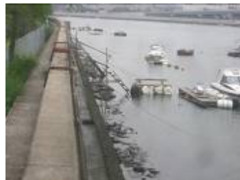
昇降梯子による 河川護岸の損傷(元安川)
