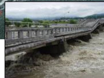
被災を受けた橋梁の例
