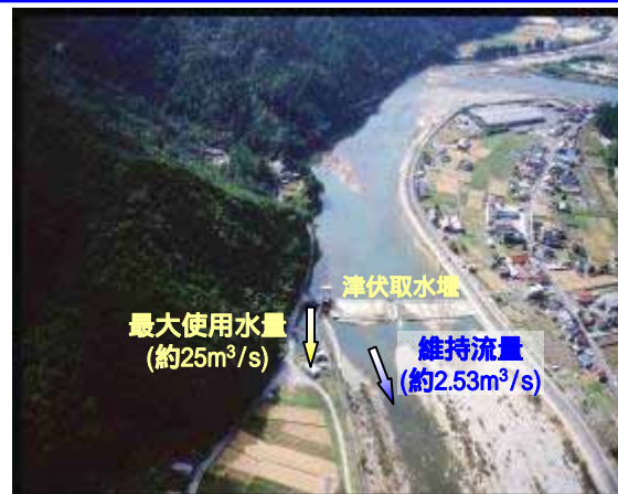
ガイドラインによる維持流量が設定されている津伏取水堰
