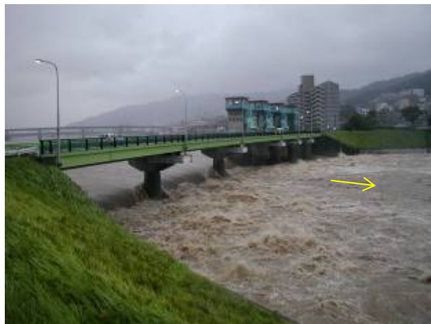
洪水時の 大芝水門下流 (平成17年9月洪水)
