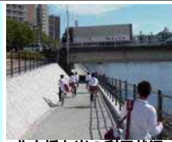
北大橋左岸の利用状況
