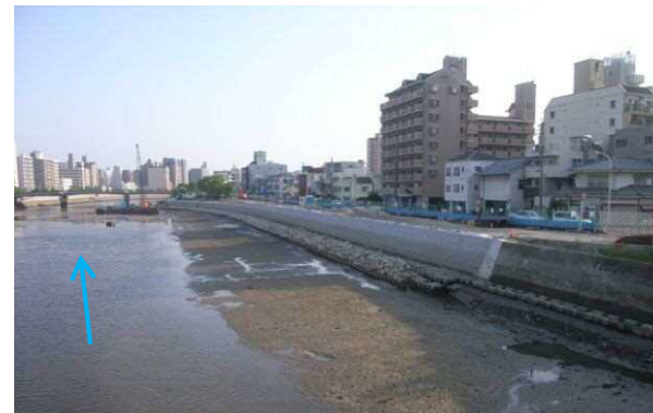
7 耐震矢板完了
