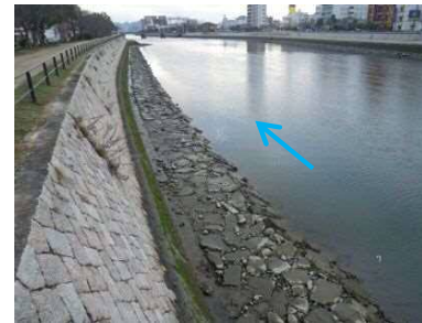
高潮堤防整備状況 (元安川 1.0K 左岸)
