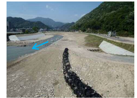
根谷川高松橋上流堤防整備及び河道掘削状況 (広島市安佐北区可部)
