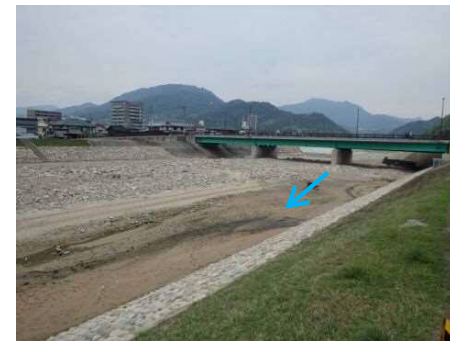
根谷川高松橋下流河道掘削状況 (広島市安佐北区可部)
