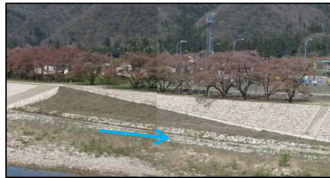
太田川上殿地先整備状況
