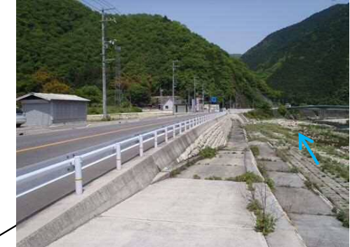
輪中堤と宅地嵩上げによる改修が完成 (広島市安佐北区安佐町大小河内)
