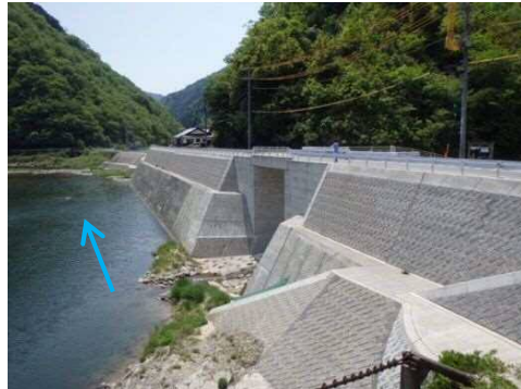
輪中堤と宅地嵩上げによる改修が完成 (広島市安佐北区安佐町大字久地)
