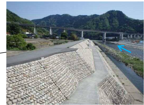
堤防整備による改修が完成 (広島市安佐北区可部町大字勝木～安佐町大字飯室)
