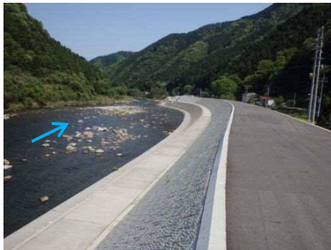
輪中堤による改修が完成 (広島市安佐北区安佐町大字後山)
