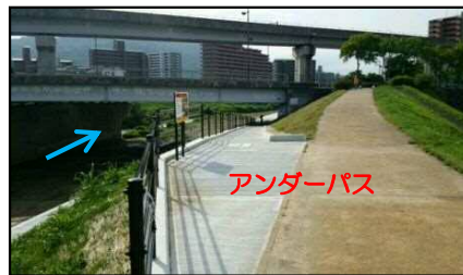
古川昭和橋アンダーパス整備状況
