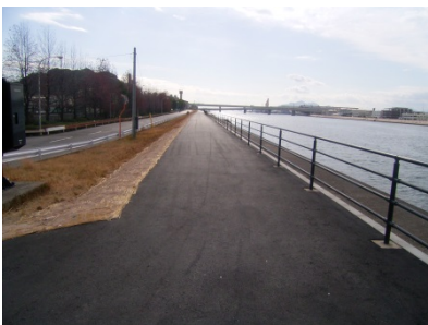
堤防天端の保護（天満川-0k500左岸付近）
