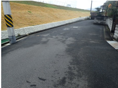
浸透対策実施箇所（太田川19k400右岸付近）
