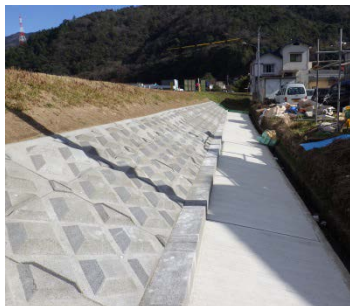
法尻補強実施箇所（三篠川6k200左岸付近）
