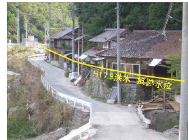
中流部の被災痕跡水位
