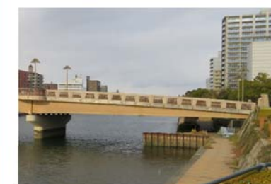
空洞化対策実施後(市内派川)
