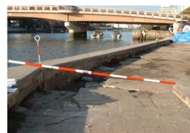
空洞化による天端の陥没(市内派川)
