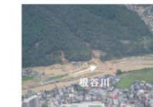
平成26年8月豪雨時の様子 (安佐北区可部東地区)
