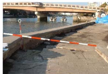
空洞化による天端の陥没(市内派川)
