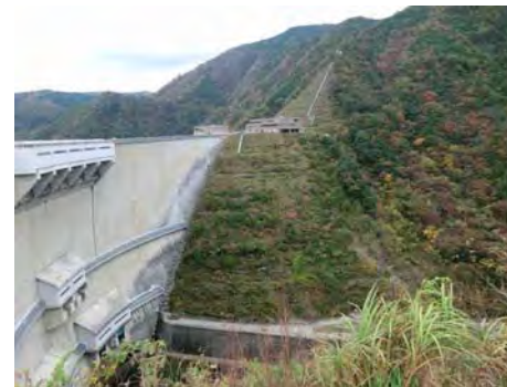
ダム堤体下流の植生の状況 (左岸側)
