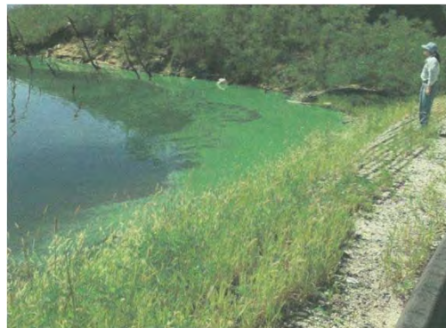
ダム上流右岸管理道②(9月5日):アオコ発生状況
