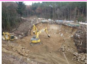
砂防事業掘削残土
