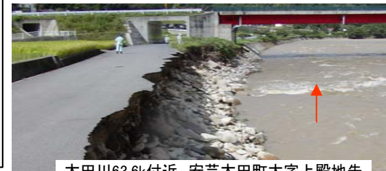
太田川63.6k付近 安芸太田町大字上殿地先
