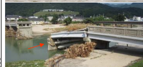
三篠川5.9k付近 鳥声橋の流出
