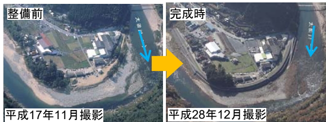
つせ 筒瀬地区(堤防整備、掘削)
