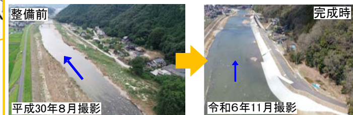
たるはら 樽原地区(堤防整備、掘削)
