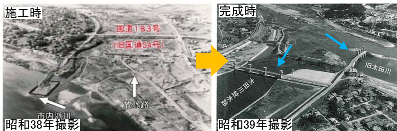
太田川放水路整備状況
