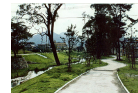
第一古川散策路(施工直後)
