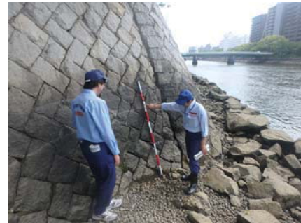
堤防点検の状況
