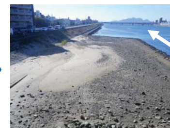
施工 8 年後 平成 30 年 7 月豪雨後
