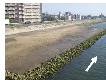
施工直後 平成 22 年 3 月
