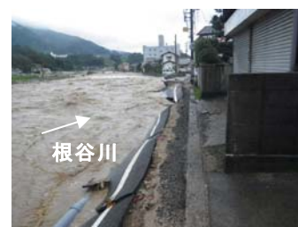
平成26年8月豪雨時の様子 (安佐北区可部地区)
