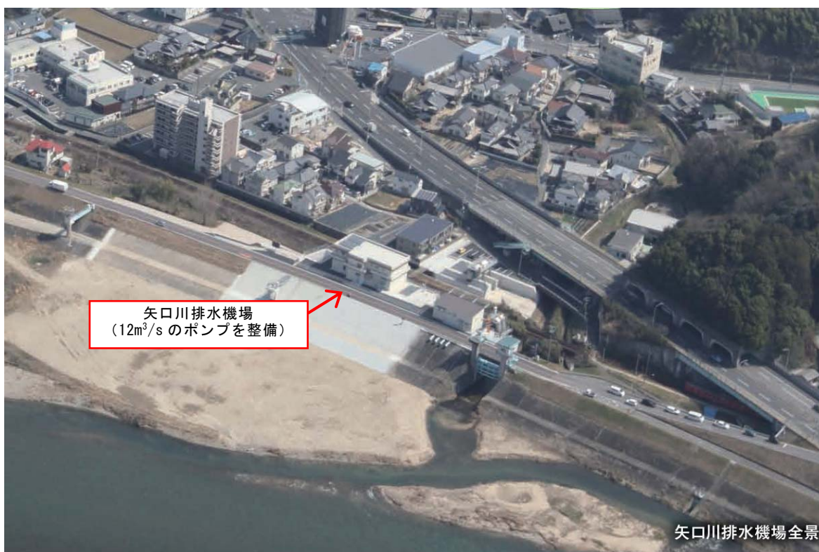
矢口川排水機場
