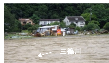
平成30年7月豪雨時の様子 (三篠川右岸 3k000 付近)
