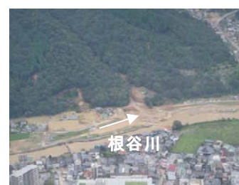
平成26年8月豪雨時の様子 (安佐北区可部東地区)
