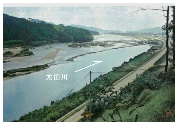
建設前(昭和46年9月)
