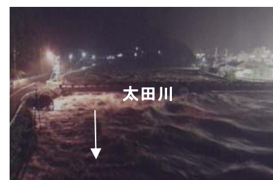
平成17年9月洪水時の様子 (太田川61.7k 堂見橋下流右岸)
