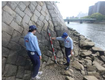
堤防点検の状況
