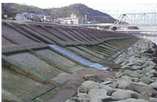
空洞化により歪みが生じている護岸(放水路)
