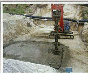
パワーブレンダー工法施工状況
