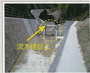
流木捕捉工完成状況
