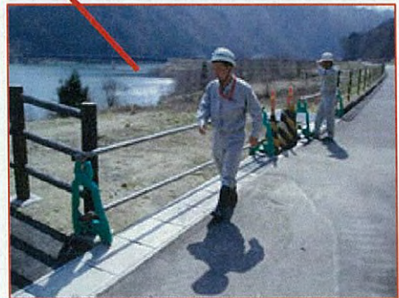
3. その他砂防堰堤に付属した施設の安全性の状況を確認します。
