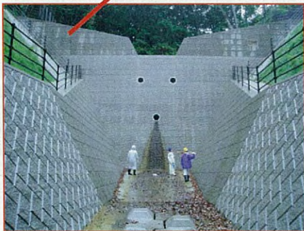
2. 砂防堰堤周辺の安全性を確認します。
