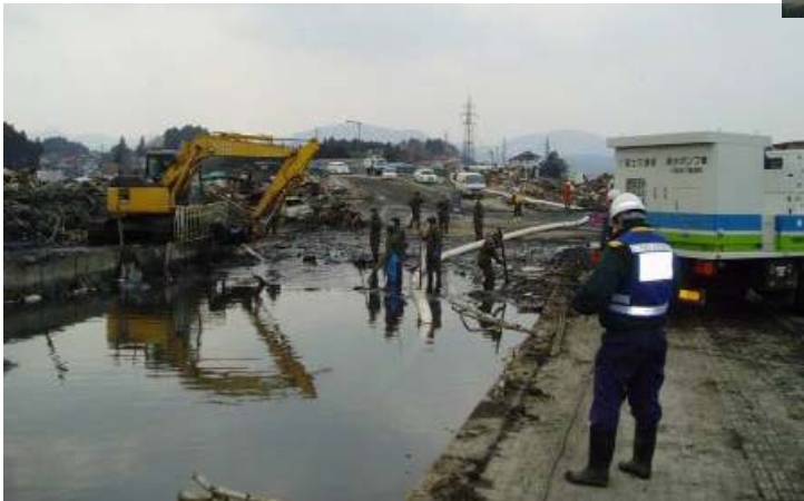
←緊急排水作業のため 排水ポンプ車の稼働状況
