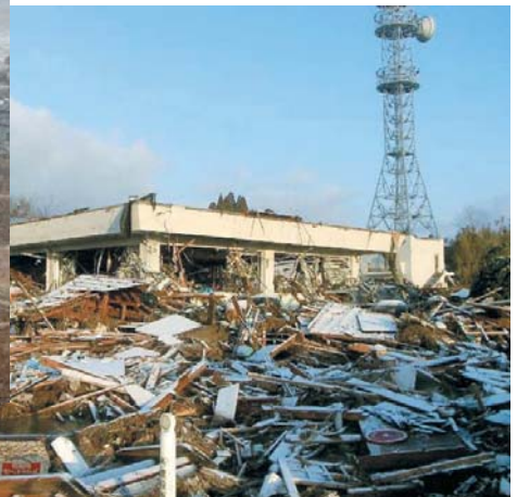
被災した国土交通省仙台河川国道事務所 気仙沼国道維持出張所
