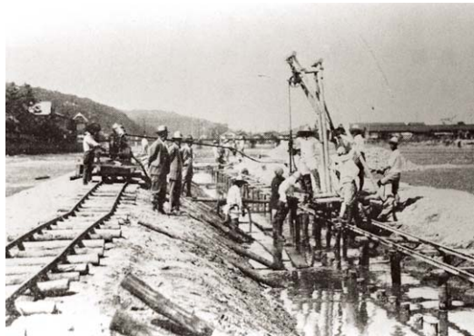
放水路建設の様子 (映画「太田川放水路」より)
