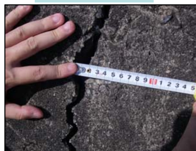
護岸のクラック (小瀬川)
