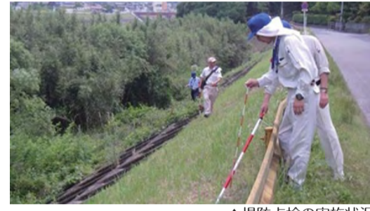
▲堤防点検の実施状況
