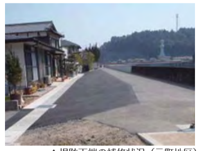
▲堤防天端の補修状況（元町地区）
