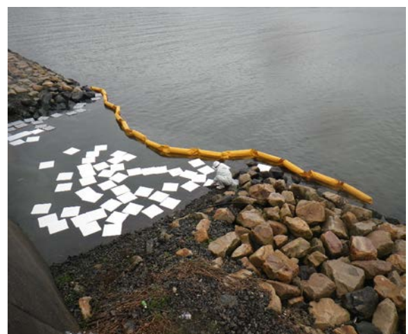
現地到着時油流出状況（和木排水樋門前）11/18 11:59 撮影 油流出対策状況（和木排水樋門前）11/18 12:48 撮影
