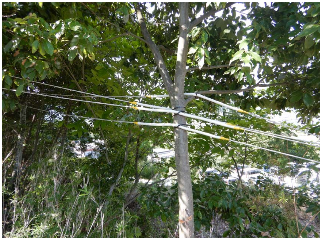
通信線の保護管設置後の状況
