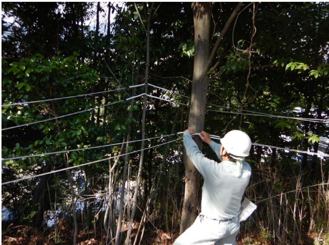
通信線の保護管設置状況
