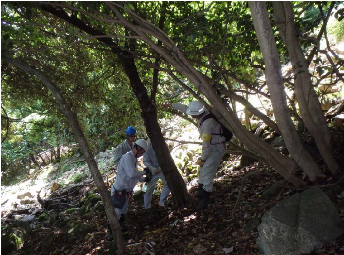
通信線の撤去作業の様子
