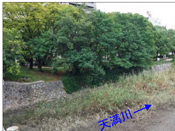
(写真②) 広瀬橋より下流の状況
