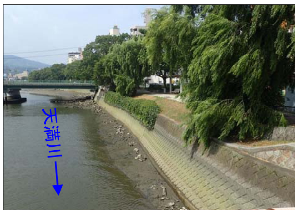
(写真①) 広電天満橋より上流の状況
