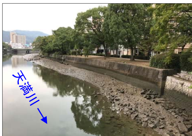
(写真①) 天満橋より上流の状況
