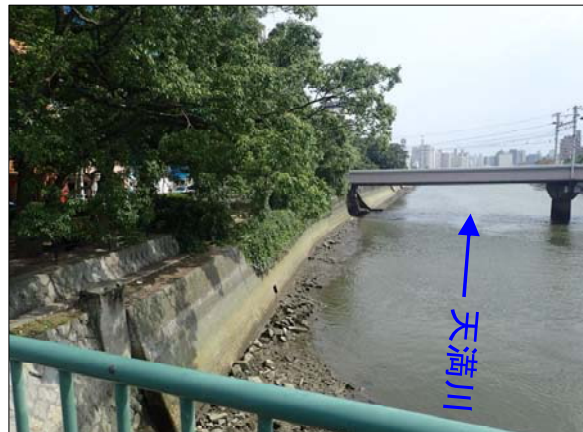
(写真②) 天満橋より下流の状況
