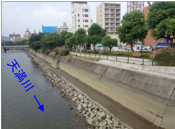
(写真①) 緑大橋より上流の状況
