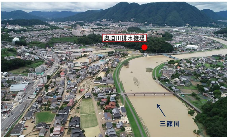
奥迫川排水機場
