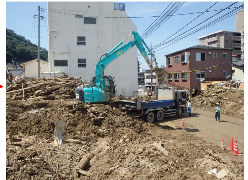
重機による進入路の確保(安佐北区口田南3丁目)
