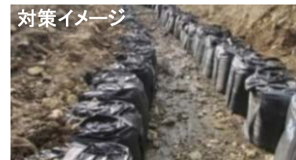
○大型土のうによる流路
