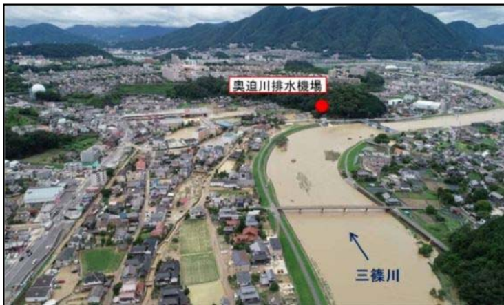
奥迫川排水機場
