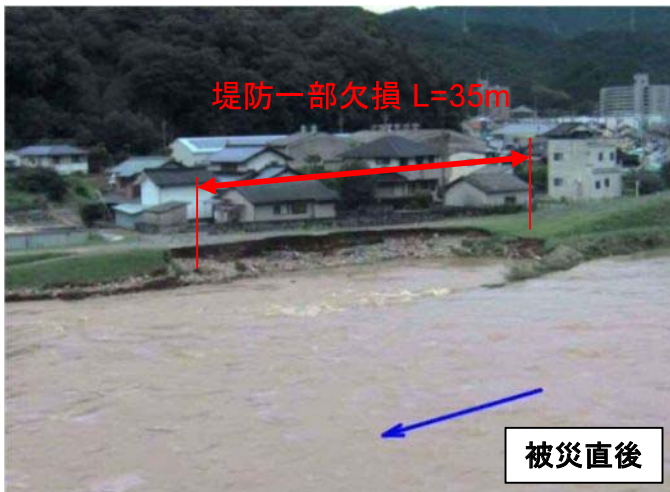
【緊急対策工事状況】
