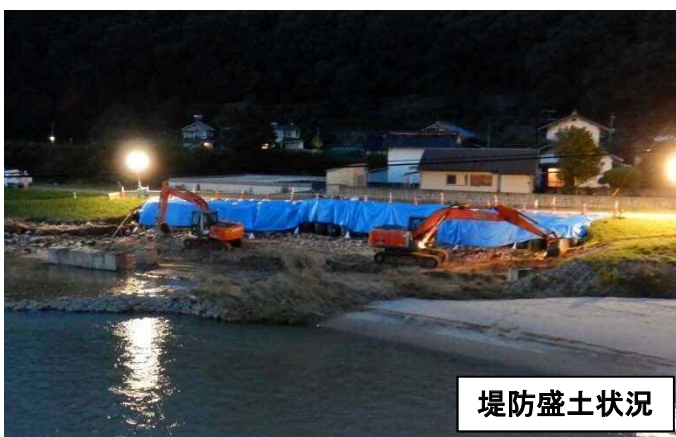
【緊急対策工事内容】
