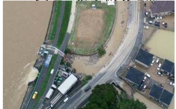
奥迫川排水機場地点
