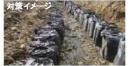
○大型土のうによる流路
