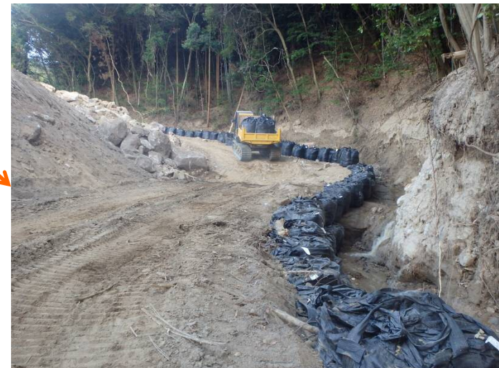
流路工が完成(7/23)
