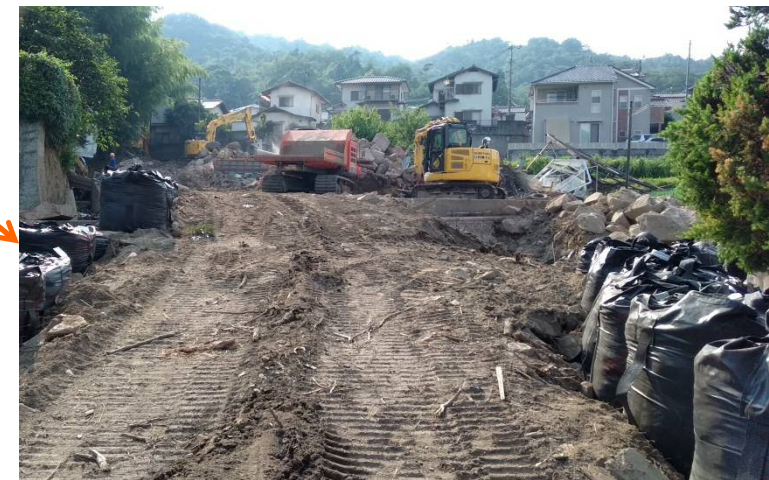
工事用道路(下流部)の延伸 ※)ガレキ撤去含む
