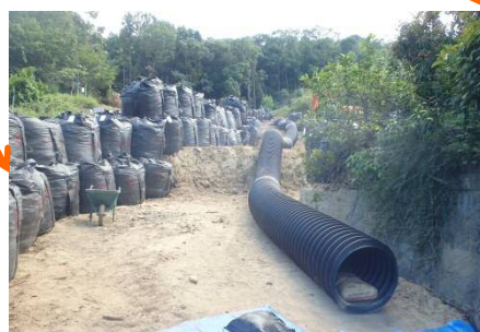
流路工(流末部)の状況 市道横断部の施工協議中
