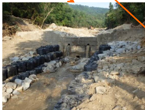
流路工が完成(7/18) (堰堤下流の洗掘防止)
