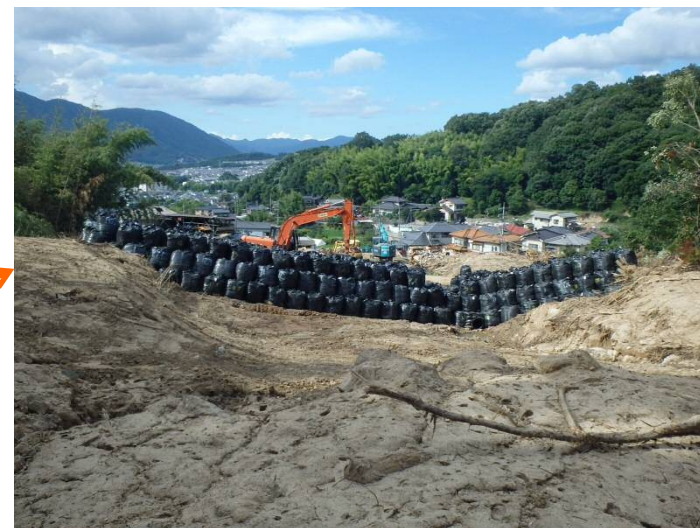
導流工が完成(7/22)
