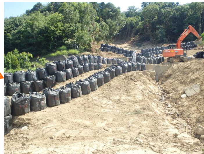
流路工の流路部分が完成(7/24)
