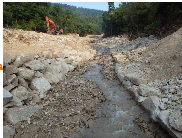
第1堰堤背面の掘削が完了(7/17) (流路断面の確保)
