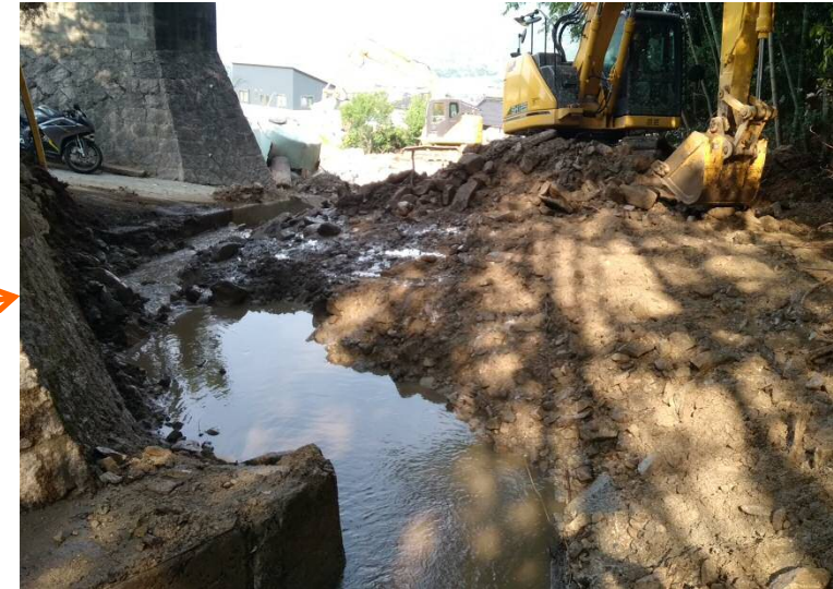
流路工の延伸 (流路部の堆積土砂撤去状況)
