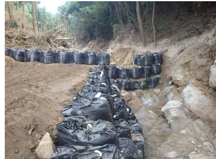
導流工が完成(7/24)
