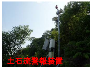
土石流警報装置設置完了(7/19)
