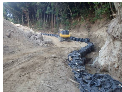
流路工が完成(7/23)
