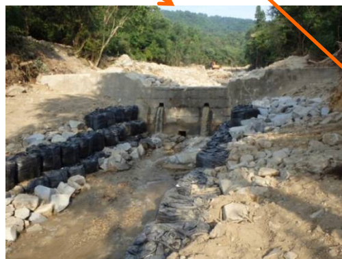
流路工が完成(7/18) (堰堤下流の洗掘防止)
