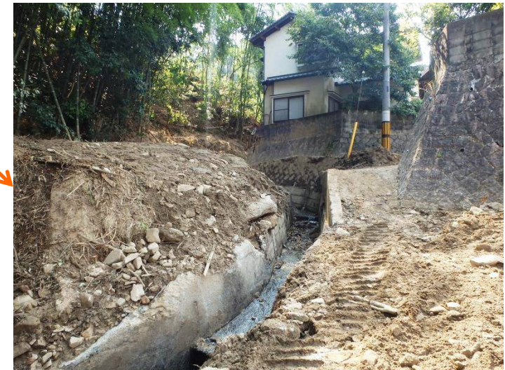
既設水路の堆積土砂撤去完了 (下流流路部)
