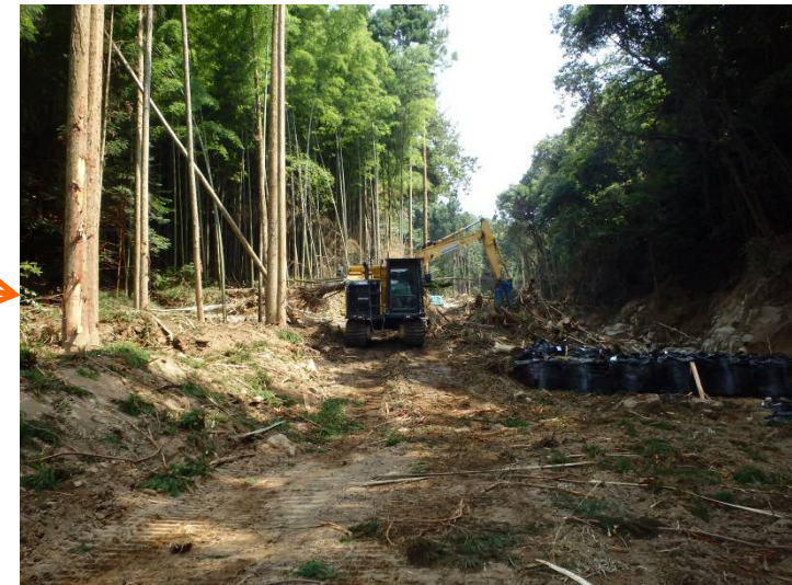
ワイヤーネット進入路整備に着手(7/26)
