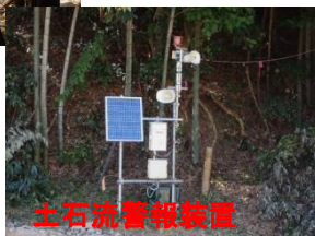
土石流警報装置設置完了(7/19)
