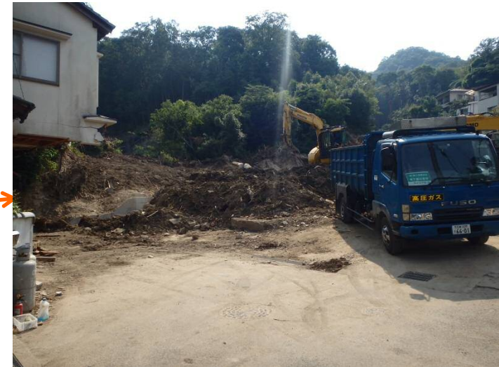
工事用道路(上流部)の延伸 ※)ガレキ撤去含む
