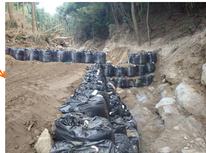
導流工が完成(7/24)
