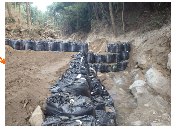
導流工が完成(7/24)
