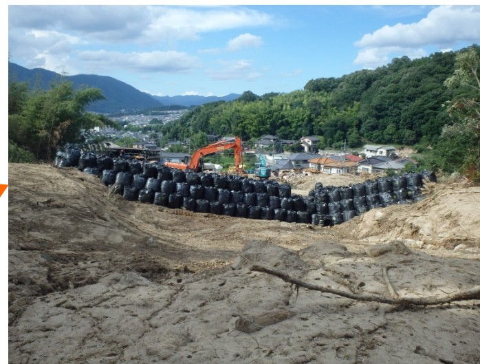
導流工が完成(7/22)
