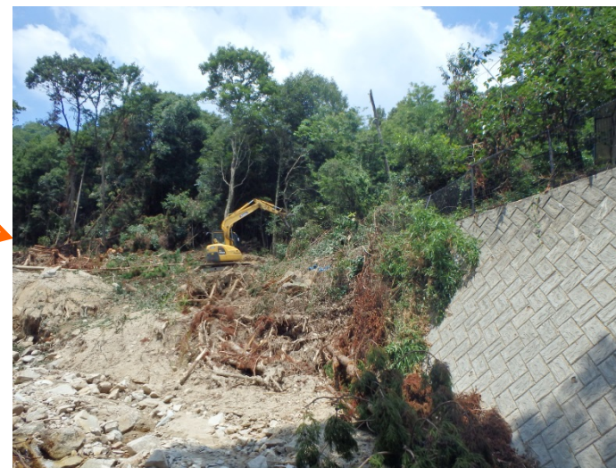
ワイヤーネットの進入路整備に着手
