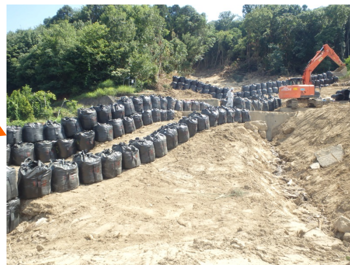
流路工の流路部分が完成(7/24)
