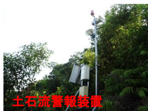
土石流警報装置設置完了(7/19)
