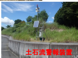
土石流警報装置設置完了(7/19)
