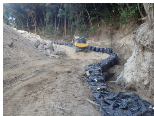
流路工が完成(7/23)
