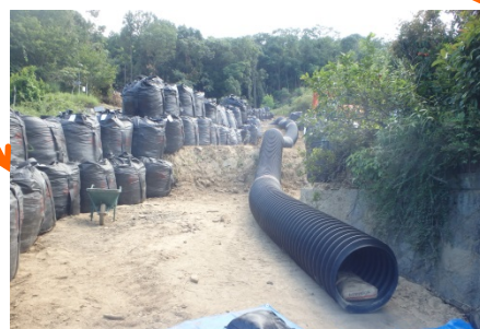
流路工(流末部)の状況 市道横断部の施工協議中
