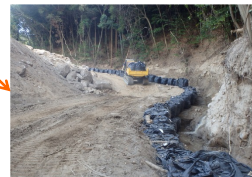
流路工が完成(7/23)
