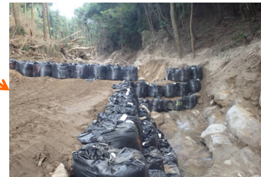
導流工が完成(7/24)
