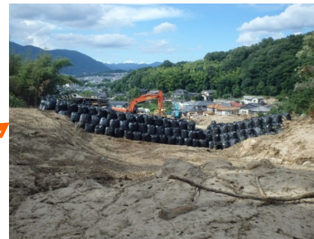
導流工が完成(7/22)
