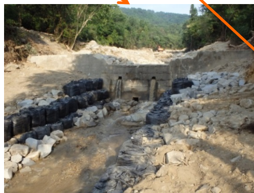
流路工が完成(7/18) (堰堤下流の洗掘防止)
