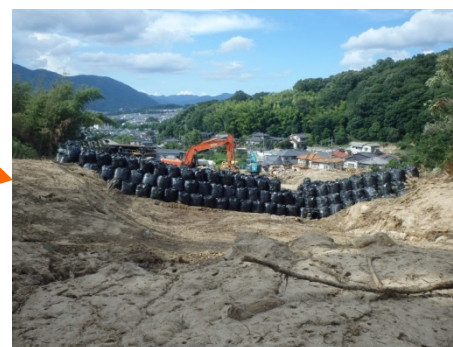
導流工が完成(7/22)
