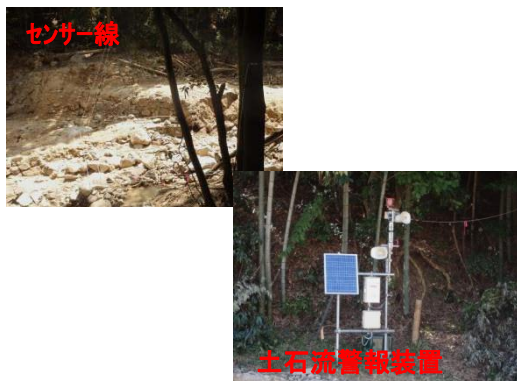
土石流警報装置設置完了(7/19)
