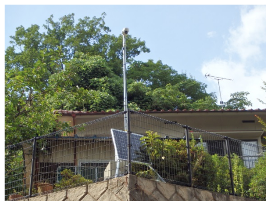
監視カメラ設置完了(7/28)
