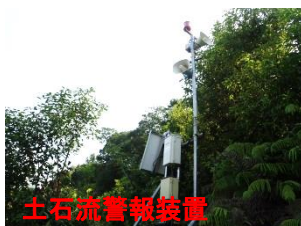
土石流警報装置設置完了(7/19)
