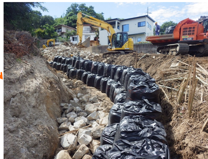
流路工の促進(上流側)
