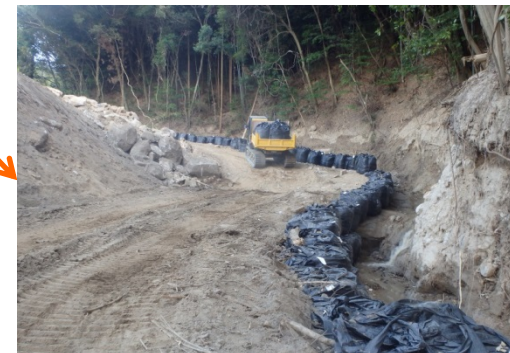
流路工が完成(7/23)
