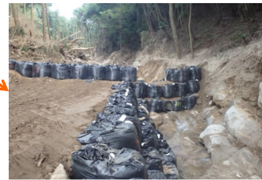
導流工が完成(7/24)
