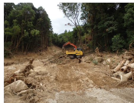
ワイヤーネット進入路整備に着手
