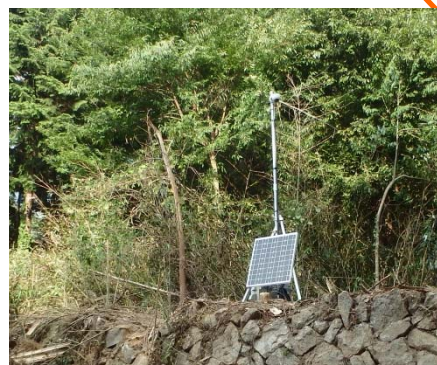
監視カメラ設置完了(7/28)
