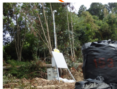
監視カメラ設置完了(7/28)
