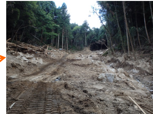
ワイヤーネット進入路が完成(7/31)
