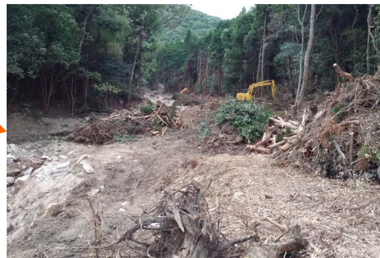
ワイヤーネットの進入路の延伸
