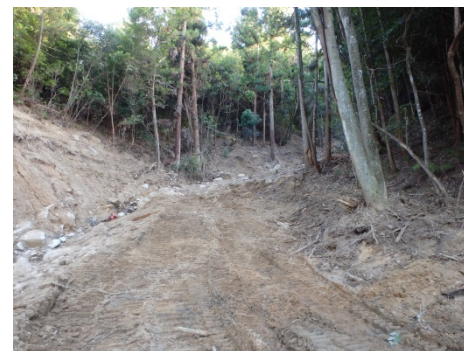
ワイヤーネット進入路が完成(7/31)
