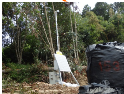
監視カメラ設置完了(7/28)
