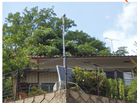
監視カメラ設置完了(7/28)
