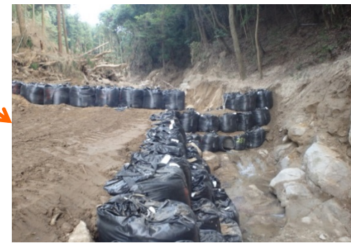
導流工が完成(7/24)
