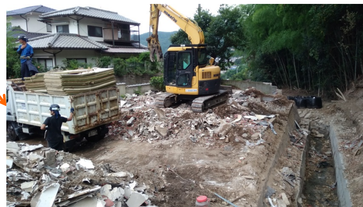
工事用道路の促進(上流側)
