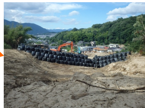
導流工が完成(7/22)
