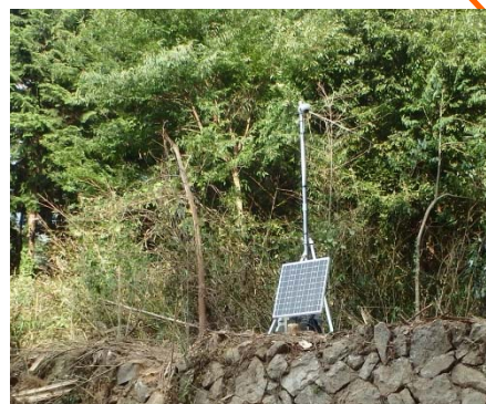
監視カメラ設置完了(7/28)
