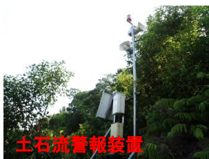
土石流警報装置設置完了(7/19)
