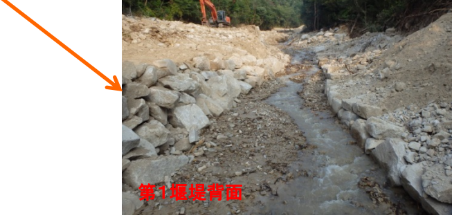
堰堤背面の掘削が完了(7/17) (流路断面の確保)
