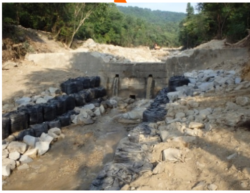
流路工が完成(7/18) (堰堤下流の洗掘防止)
