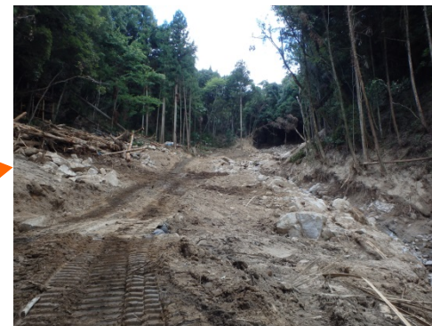
ワイヤーネット進入路が完成(7/31)
