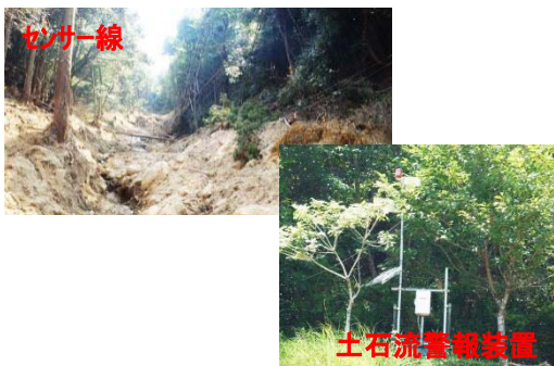
土石流警報装置設置完了(7/19)
