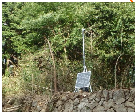
監視カメラ設置完了(7/28)
