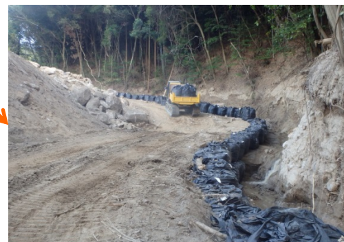
流路工が完成(7/23)
