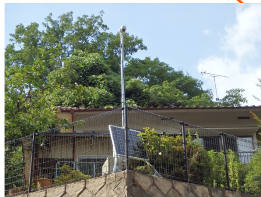
監視カメラ設置完了(7/28)
