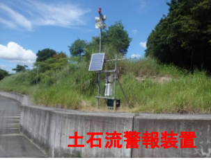
土石流警報装置設置完了(7/19) 監視カメラ設置完了(7/28)
