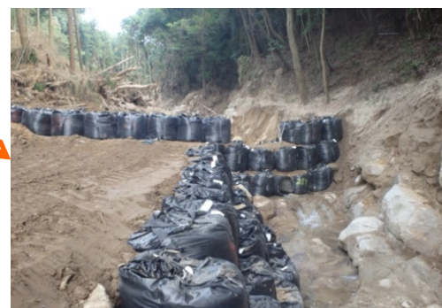
導流工が完成(7/24)
