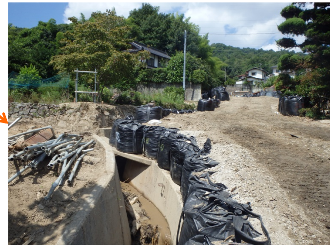
下流側流路工が完成(8/1)
