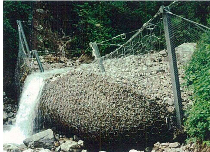
土石流の捕捉状況
