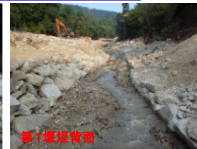
堰堤背面の掘削が完了(7/17) (流路断面の確保)
