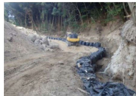
流路工が完成(7/23)
