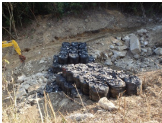
導流工が完成(8/3)
