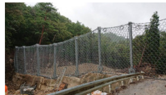
ワイヤーネット工(本川)が完成(8/31)
