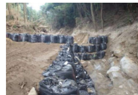
導流工が完成(7/24)
