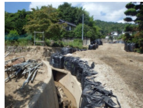
流路工(下流側)が完成(8/1)
