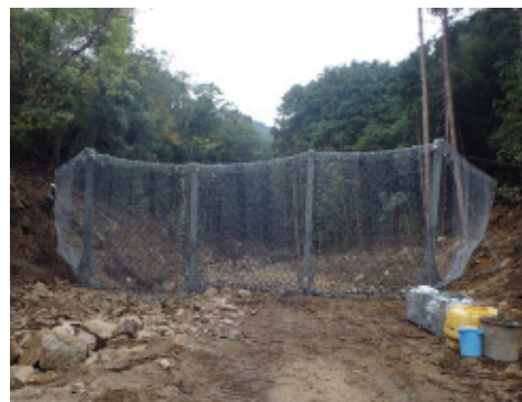
ワイヤーネット工完成(10/10)
