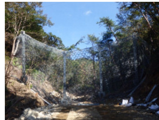
ワイヤーネット工(支川)が完成(10/13)
