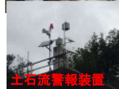
土石流警報装置完了(9/28)
