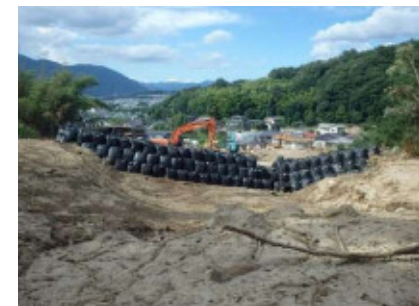
導流工が完成(7/22)
