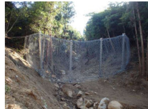
ワイヤーネット工が完成(8/30)
