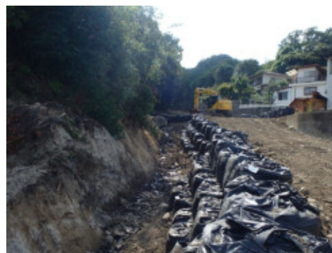
流路工(上流側)が完成(8/6)
