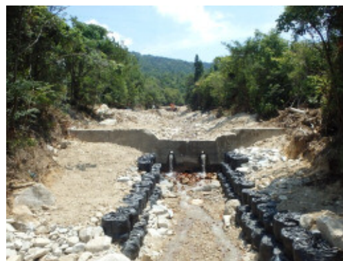
流路工が完成(7/18) (堰堤下流の洗掘防止)
