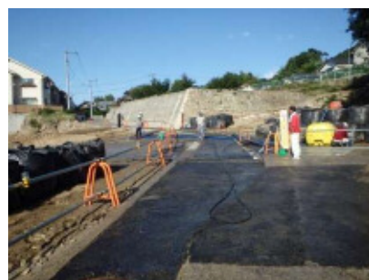
市道の仮復旧完了(9/5)
