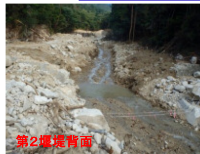
堰堤背面の掘削が完了(7/17) (流路断面の確保)
