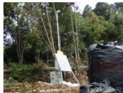
監視カメラ設置完了(7/28)
