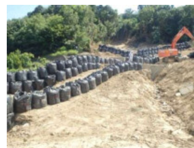
流路工が完成(7/30)
