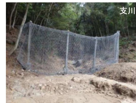
ワイヤーネット工完成(本川9/12、支川9/17)
