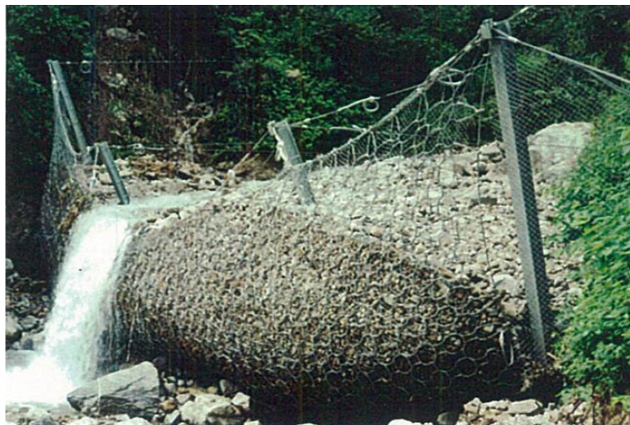
土石流の捕捉状況
