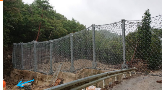
強靱ワイヤーネット設置状況(本川)
