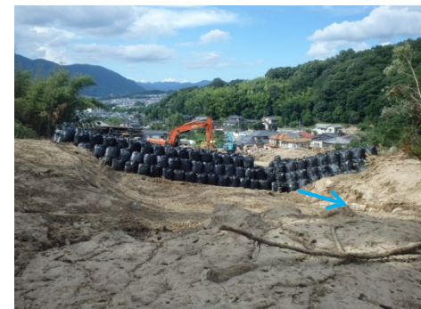
導流工実施状況
