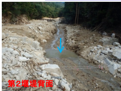
堰堤背面の掘削状況 (流路断面の確保)
