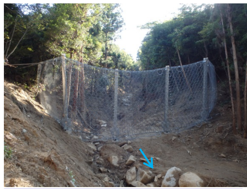
強靱ワイヤーネット設置状況
