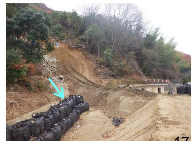
落石緩衝対策・巨石対策実施状況
