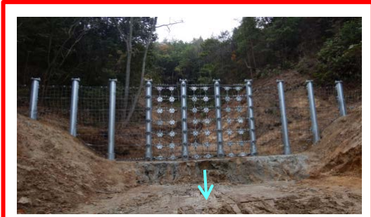
土石流応急対策工設置状況
