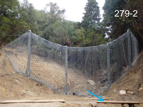
強靱ワイヤーネット設置状況
