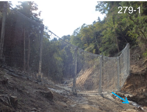
強靱ワイヤーネット設置状況
