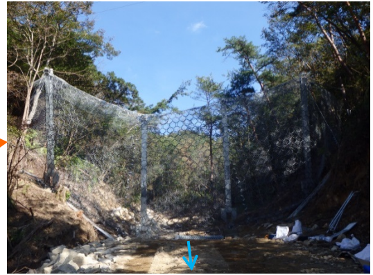
強靱ワイヤーネット設置状況(支川)
