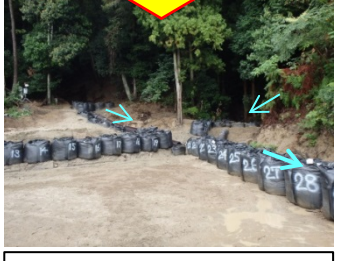
流路工(断面確保)実施状況
