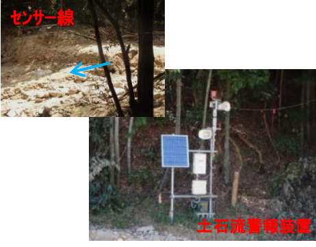
土石流警報装置設置状況
