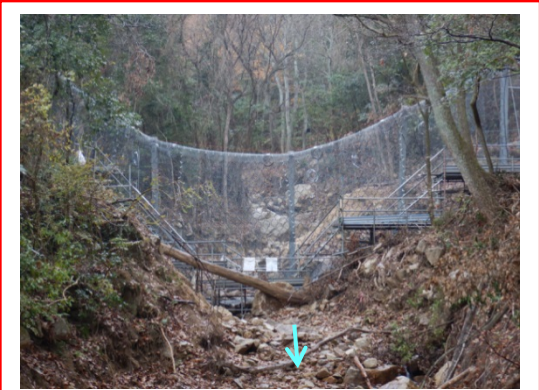
強靱ワイヤーネット設置状況
