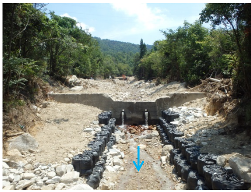
流路工実施状況 (堰堤下流の洗掘防止)
