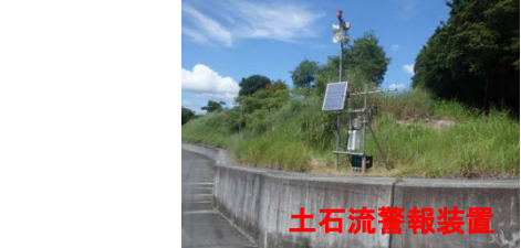
土石流警報装置設置状況
