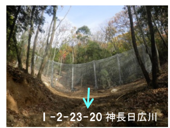
強靱ワイヤーネット設置状況
