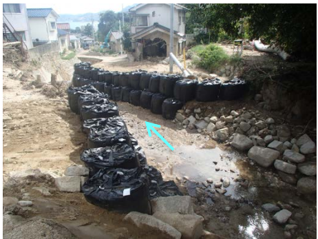
流路工(断面確保)・導流工実施状況
