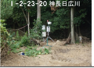
ワイヤーセンサー(警報装置)設置状況
