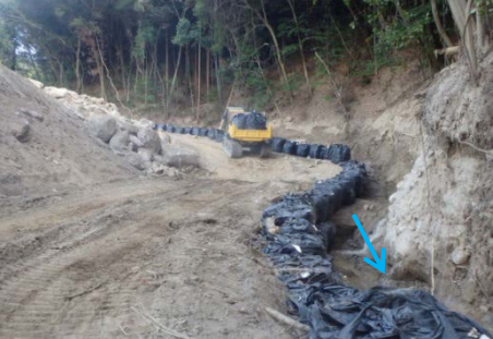
流路工実施状況
