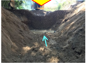
既設堰堤除石状況
