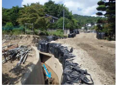
流路工(下流側)実施状況
