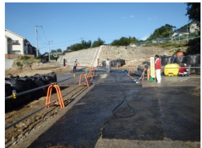
市道の仮復旧状況
