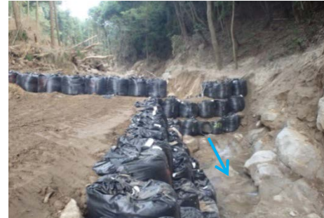
導流工実施状況
