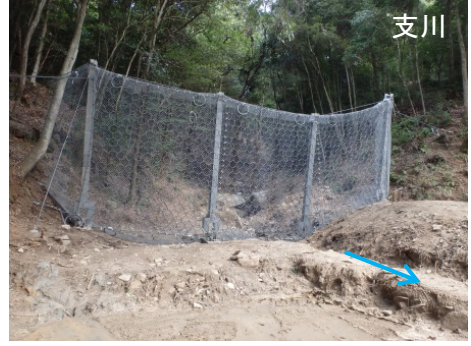
強靱ワイヤーネット設置状況
