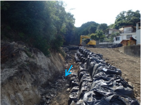
流路工(上流側)実施状況
