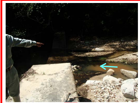
既設堰堤 除石
