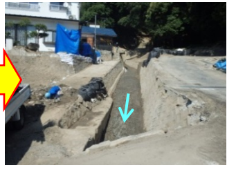
流路工(断面確保)実施状況
