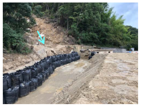
流路工・落石緩衝対策実施状況
