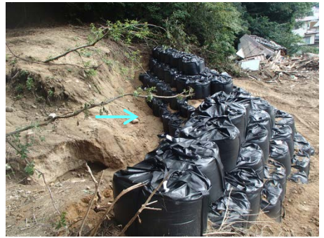
導流工実施状況
