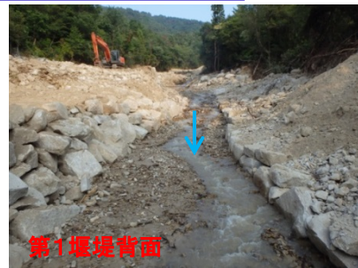
堰堤背面の掘削状況 (流路断面の確保)
