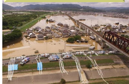
【H30.7月豪雨】 (岡山県倉敷市真備町)
