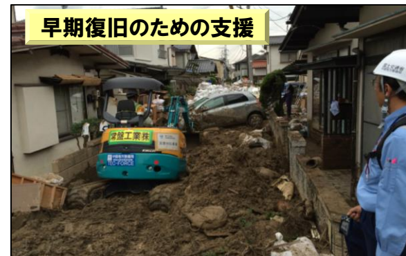
市道等に堆積した土砂を約1ヶ月で撤去
