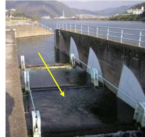
魚道の可倒式隔壁
