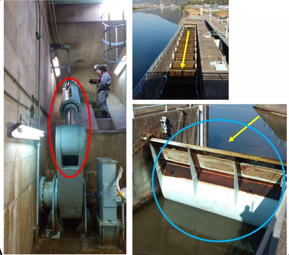
高瀬堰の水位が低い時はゲートを低く、水位が高い時はゲートを起こして高くして、水の流れ方と量を調整しているんだ！
