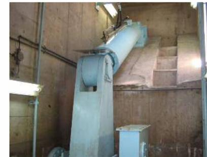
可倒式隔壁を動かすための油圧式ピストン
