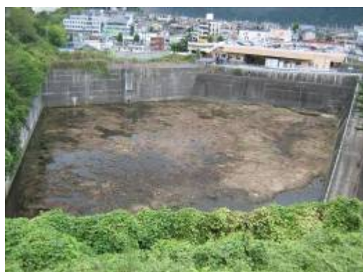
図 3-4 矢口が丘防災調整池
