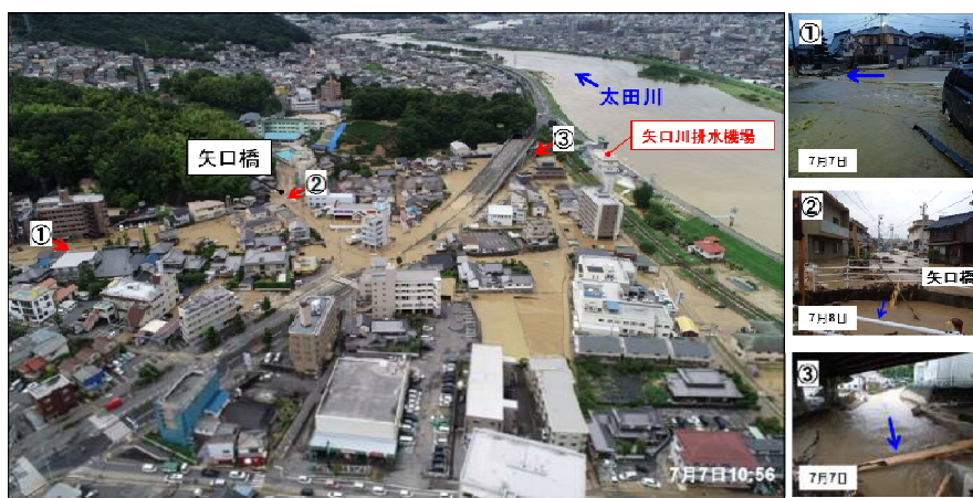
図 2-3 内水浸水状況 (平成 30 年 7 月洪水)
